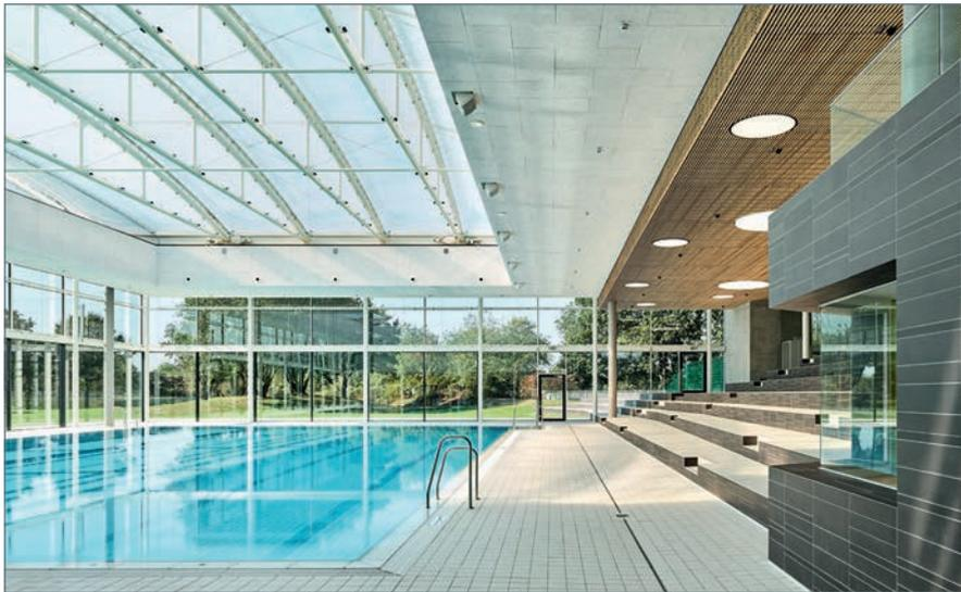
■ Das verfahrbare Dach über dem 25-m-Becken – geschlossen, ...
